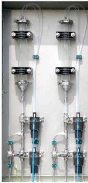
現場に設置された前処理システムの実例
